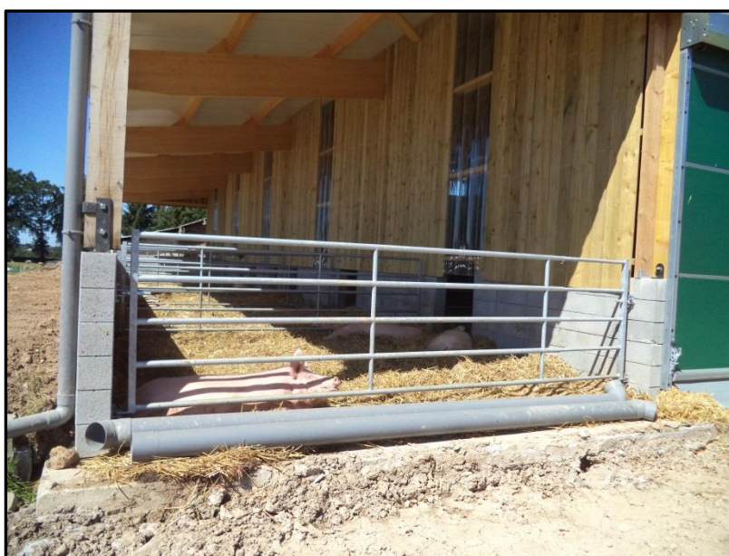
Le bâtiment des truies non allaitantes avec les courettes extérieures couvertes.
